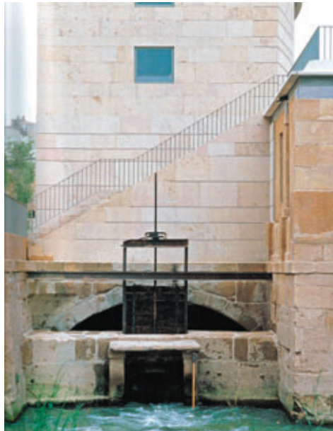
Figura 7. Juan Navarro Baldeweg, Rehabilitación Molinos del río Segura, 1984-88, Murcia.
