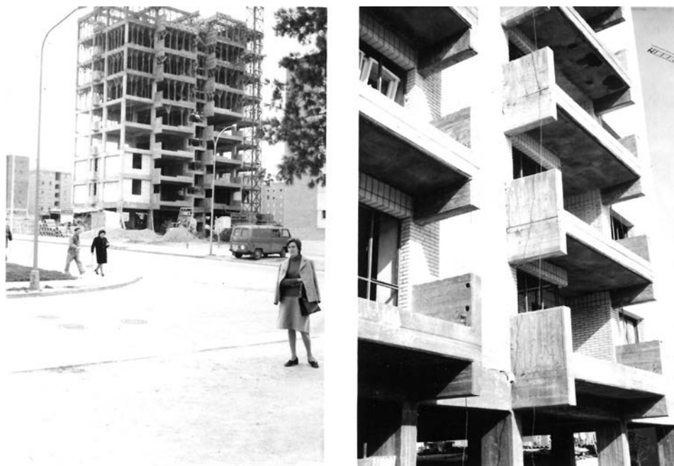
Figura 5. Torre de 24 viviendas en Moratalaz, 1972. Margarita Mendizábal en visita de obra. Detalle voladizos hormigón. Fotografía realizada por Margarita Mendizábal.
