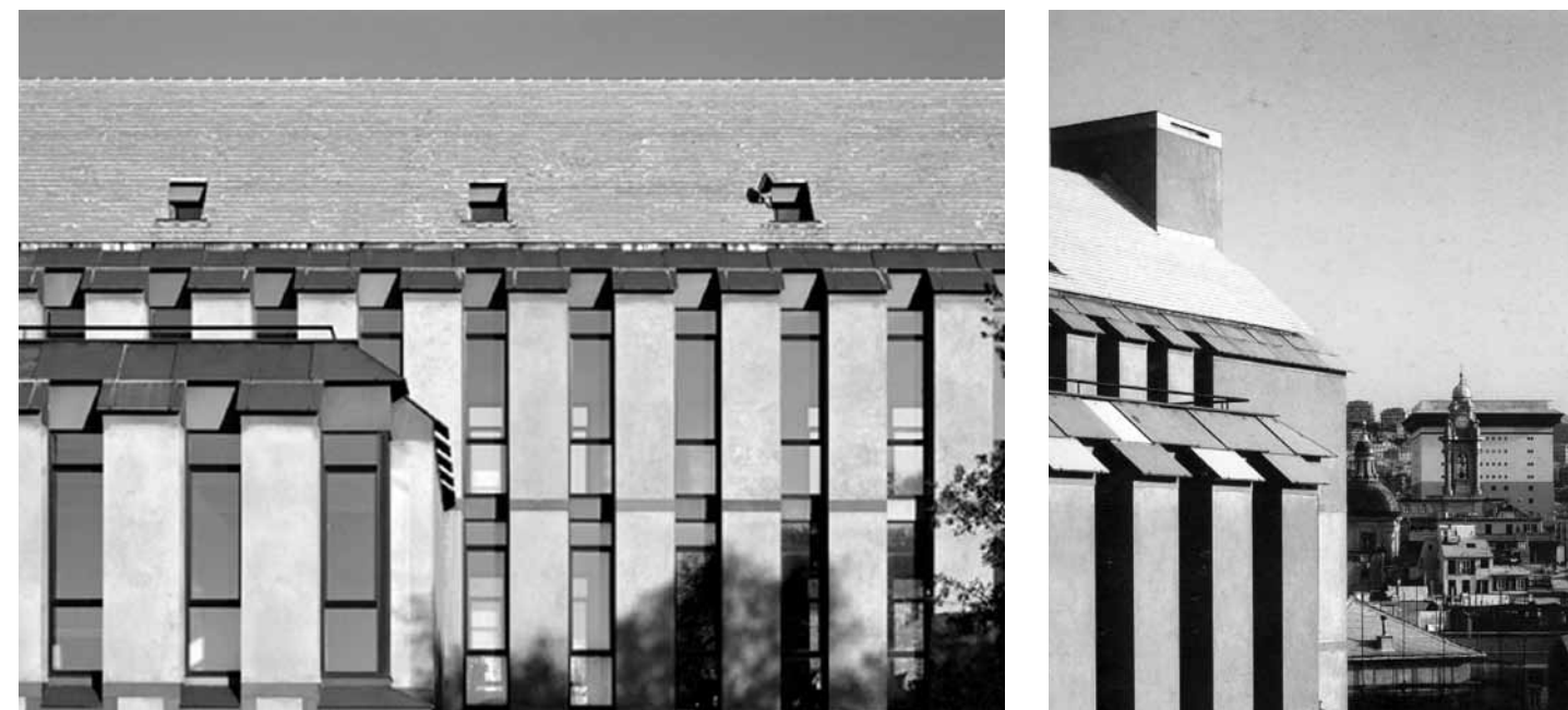
[Fig. 14] Facultad de Arquitectura de Génova, 1989. Detalle de la fachada.
