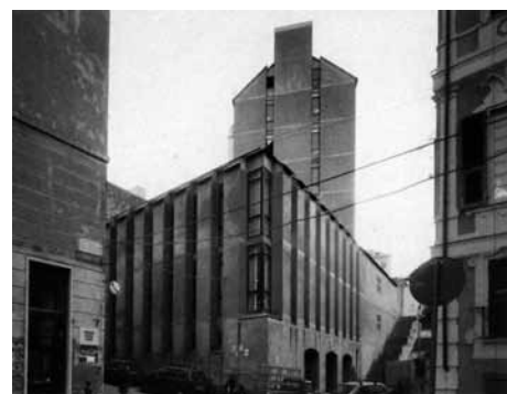
[Figs. 12-13] Facultad de Arquitectura de Génova, 1989. Vista del edificio desde la cota superior y desde la cota inferior.
