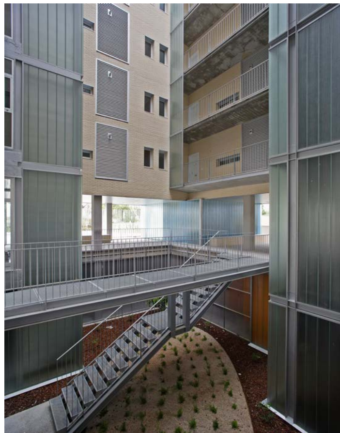
Figura 5. Espegel - Fisac, 24 viviendas en Fuenlabrada, Madrid, 2007. Figure 5. Espegel - Fisac, 24 dwellings in Fuenlabrada, Madrid, 2007.
